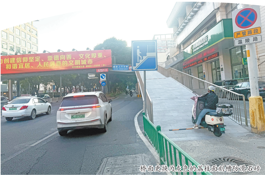
桥面更换为灰色的荔枝面刻槽防滑石砖
