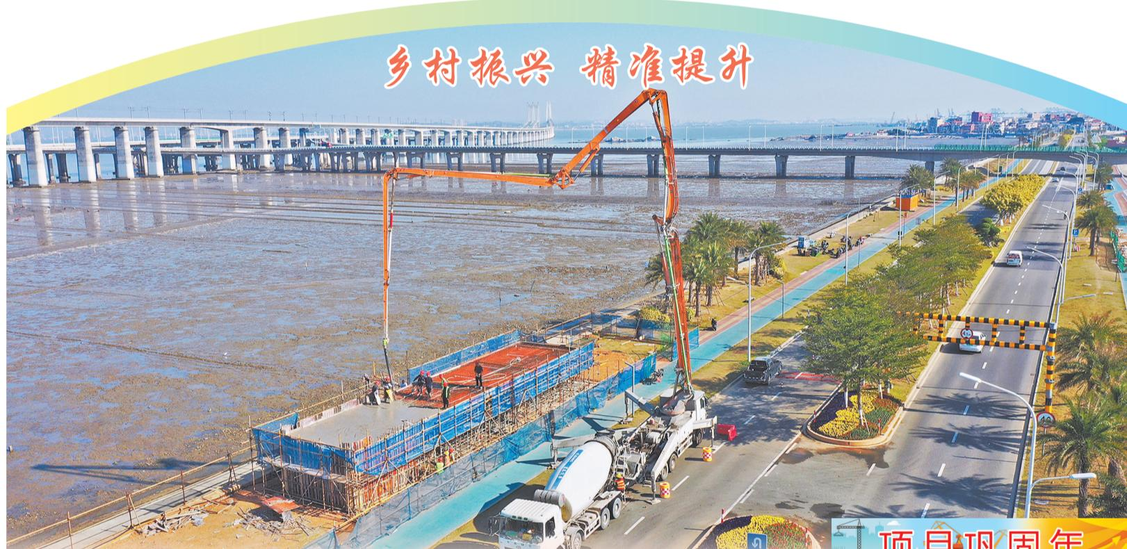
近日，记者在石狮锦江外线湿地公园段临海区域看到，作为石狮市“一县一溪一特色”乡村振兴精准提升（一期）项目——蚶江沟基础设施与生态整治建设项目的关节点，“服务驿站”工程建设现场一片繁忙，施工人员正紧张有序地进行主体楼板的混凝土浇筑作业，标志着该工程正式进入主体结构收尾阶段。该项目旨在通过系统性提升，改善区域生态环境，完善配套服务设施，打造滨海特色景观带。项目建成投用后，将进一步带动沿线乡村发展，绘就“生态美、产业兴、百姓富”的乡村振兴新画卷。
