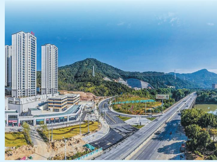
安溪参洋河滨路(西溪大桥下游段)道路工程西起东二环路口，东至经支十三路交叉口，总体呈东西走向，全长约326米，按城市次干路标准建设，红线宽度24米，采用双向四车道设计，是完善区域路网结构、提升城市承载能力的重要民生工程。目前，该项目已顺利完成预验收，正加快推进联合验收相关工作。(黄东华 摄)
