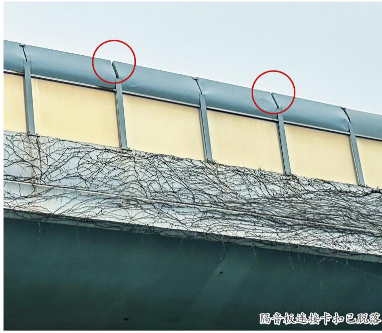
隔音板连接卡扣已脱落
