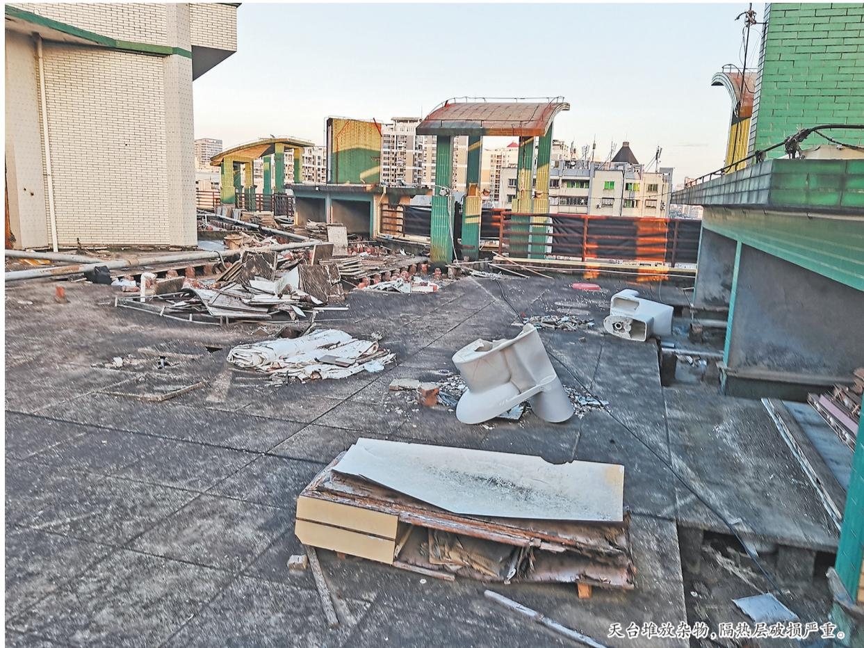
天台堆放杂物,隔热层破损严重。
