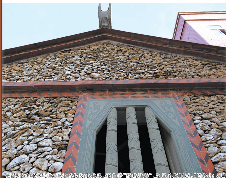
蚶壳厝以蚶壳砌墙,墙体不仅防水抗风,还自带“隔热技能”,屋里冬暖夏凉。(陈起拓 摄)
