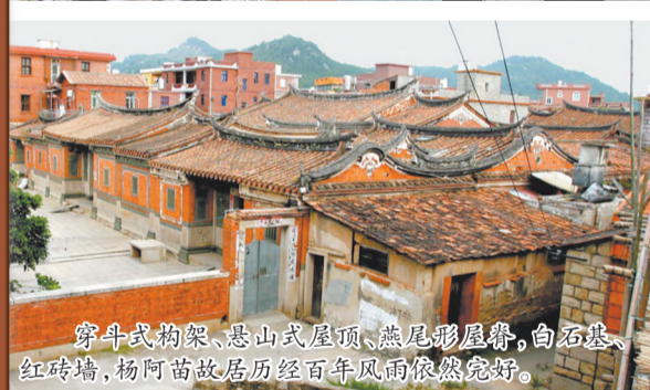
蚶壳厝以蚶壳砌墙,墙体不仅防水抗风,还自带“隔热技能”,屋里冬暖夏凉。(陈起拓 摄)
