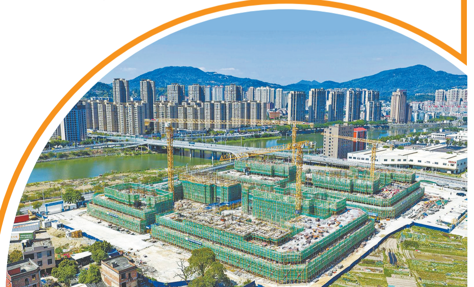
安溪同美高速出口片区B-04地块项目位于城厢镇同美村,总用地面积约45亩,总建筑面积约15万平方米,规划建设7栋高层住宅和沿街二层商业店面,并配套文体活动、社区卫生、物业管理等功能性用房,着力打造高品质安置住宅区。该项目建成投用后,可提供安置住宅684套、店面238间,有效解决680多户拆迁户安置需求。目前,1#、2#、3#楼外架在搭设中,5#、6#、7#、8#楼三层墙柱、四层梁板砼浇筑完成。(黄东华 摄)
