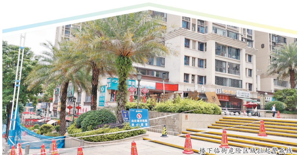
楼下临街危险区域拉起警戒线
