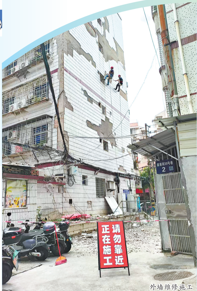
外墙维修施工
