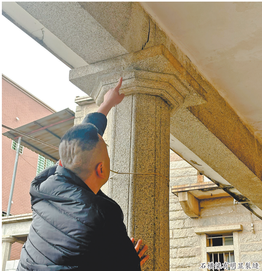
石横梁有明显裂缝
