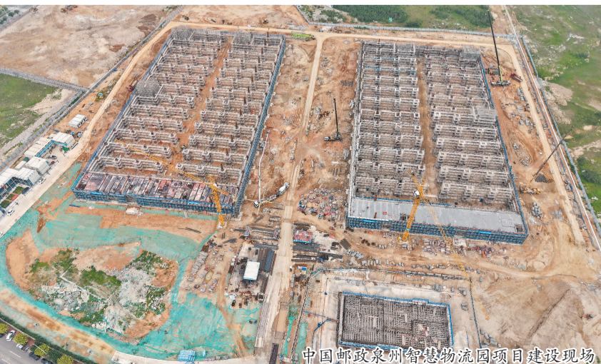
中国邮政泉州智慧物流园项目建设现场
