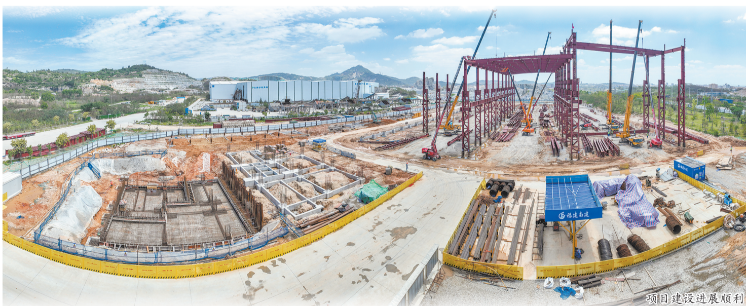
项目建设进展顺利
