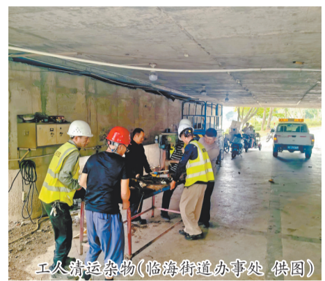
工人清运杂物(临海街道办事处供图)
