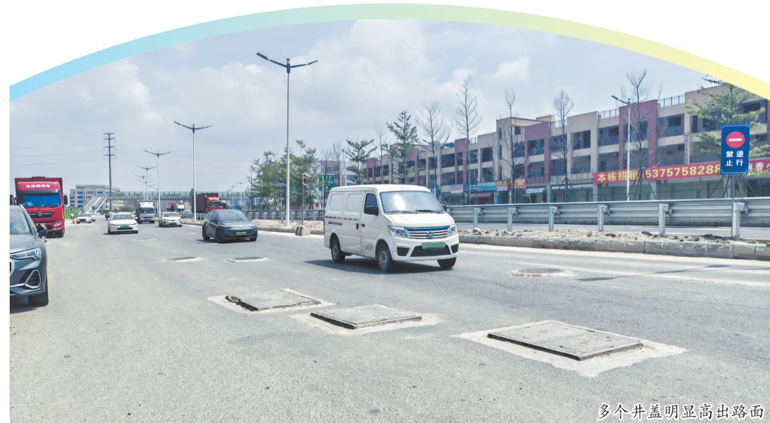
多个井盖明显高出路面
