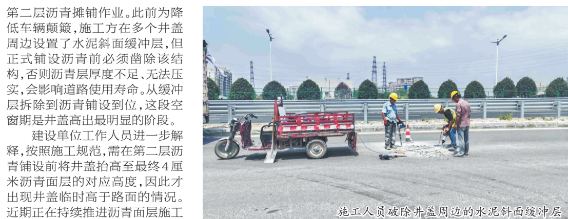
施工人员破除井盖周边的水泥斜面缓冲层
