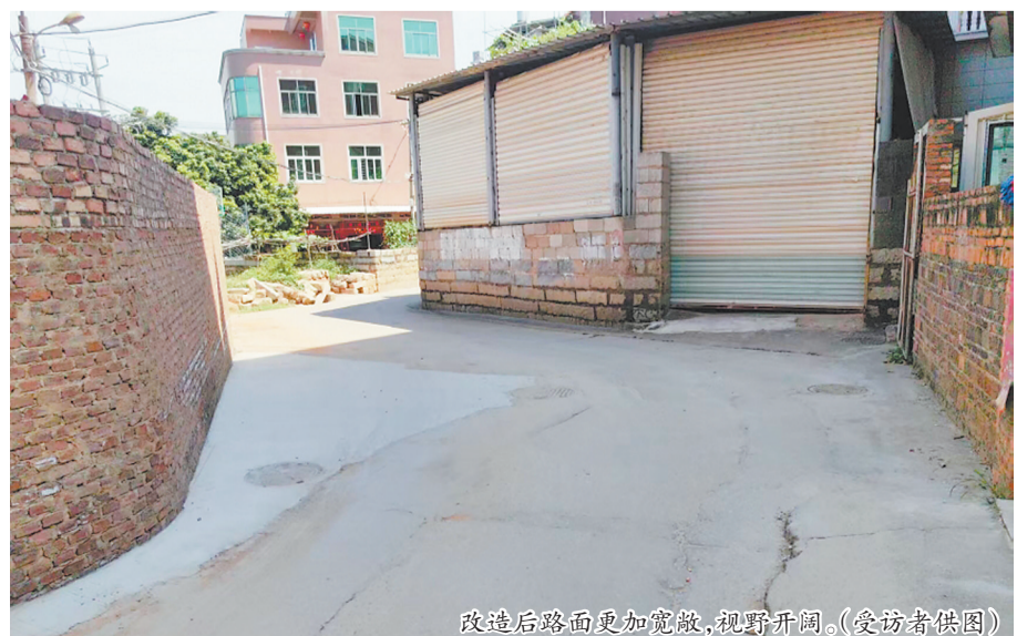
改造前90度拐角(画圈处),电线杆占道,十分不便。(受访者供图)
