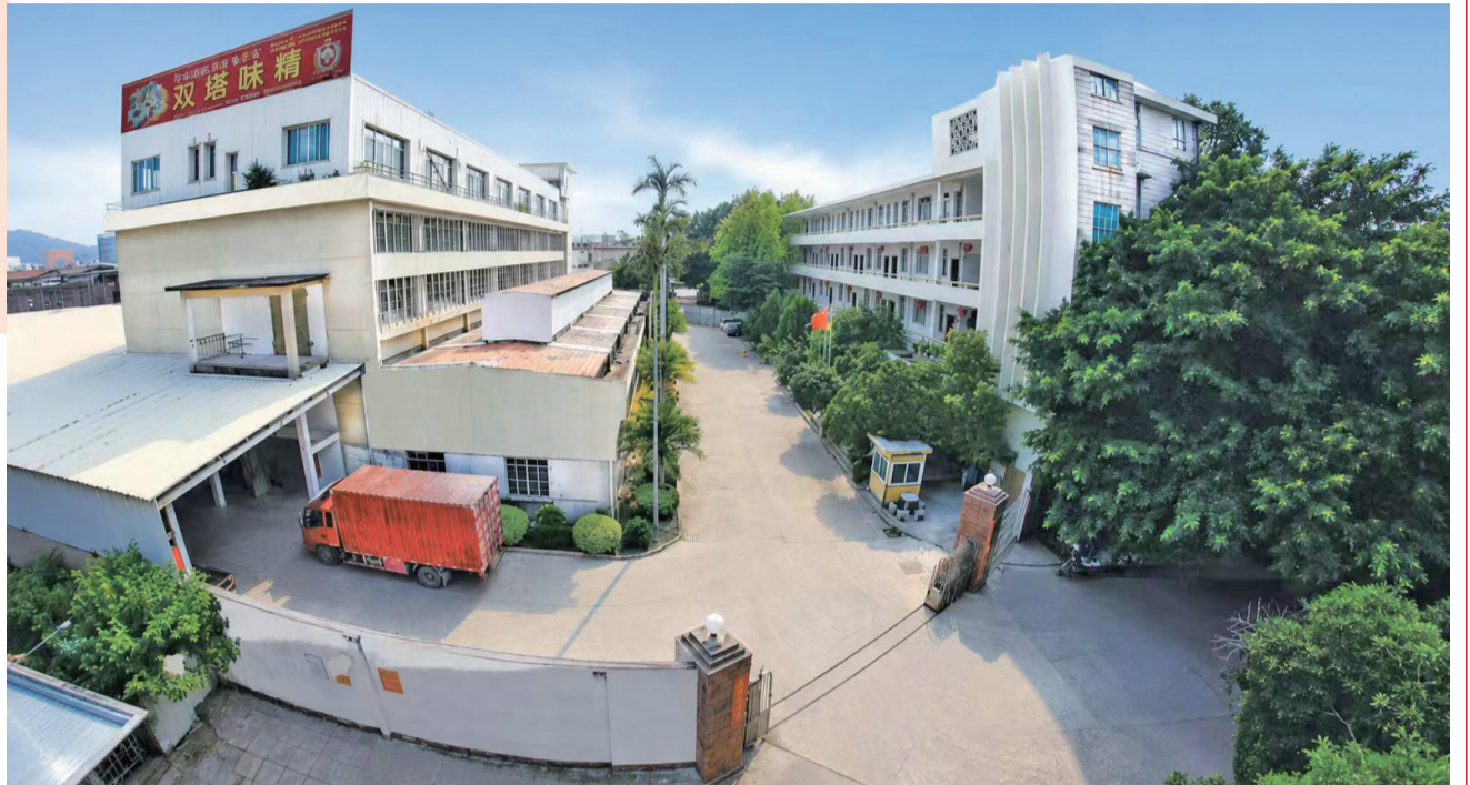
泉州中侨味精厂区俯瞰全景
