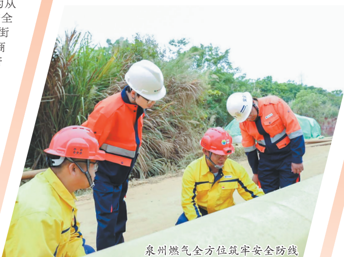
泉州燃气工作人员在第三施工现场开展拉网式风险排查
