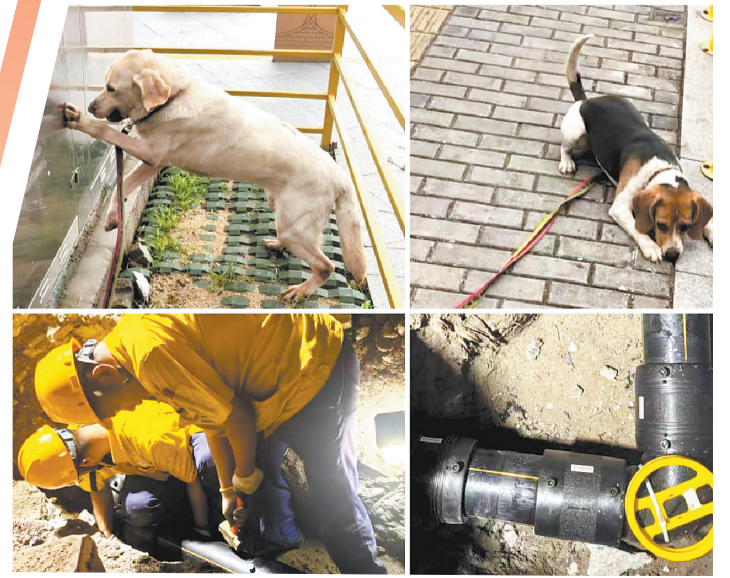
嗅探犬俯身示警,PPB级巡检车复核确认,抢修团队进场处置完成闭环,消除隐患。
