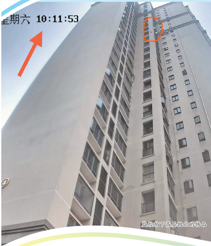
搭雨棚装监控 记录多次惊险抛物
