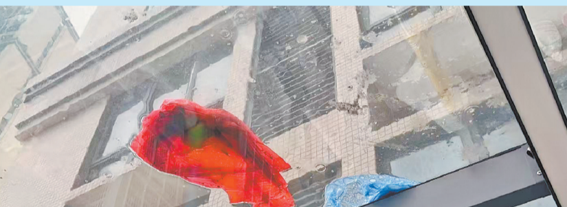
玻璃被高空抛物砸裂(杨泳红 摄)
