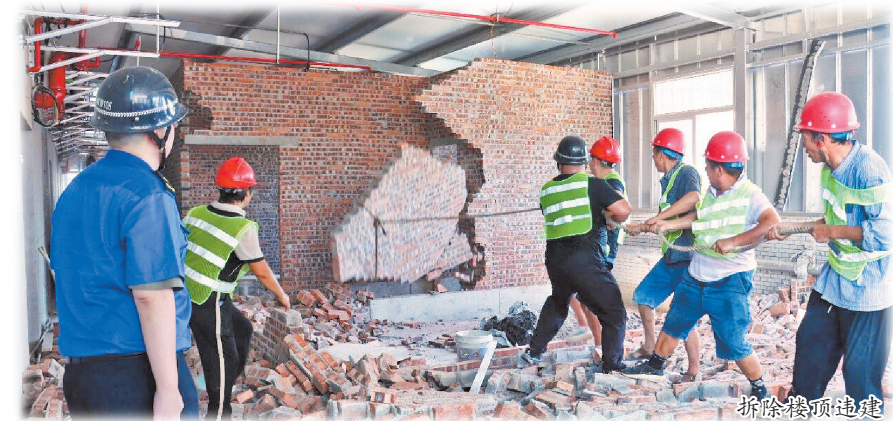
拆除楼顶违建
