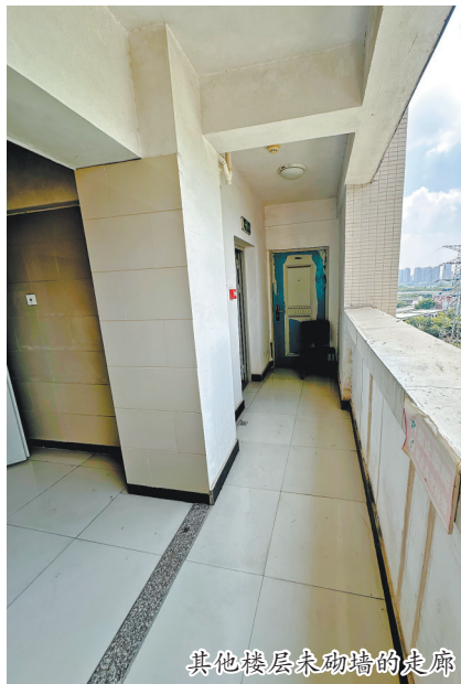
其他楼层未砌墙的走廊
