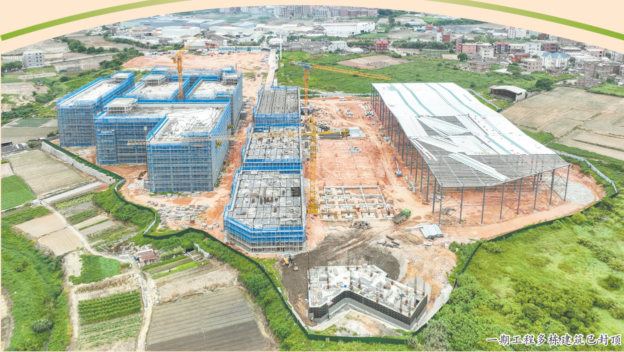
一期工程多栋建筑已封顶
