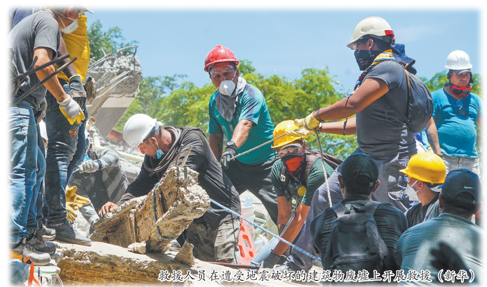
救援人员在遭受地震破坏的建筑物废墟上开展救援(新华社)
