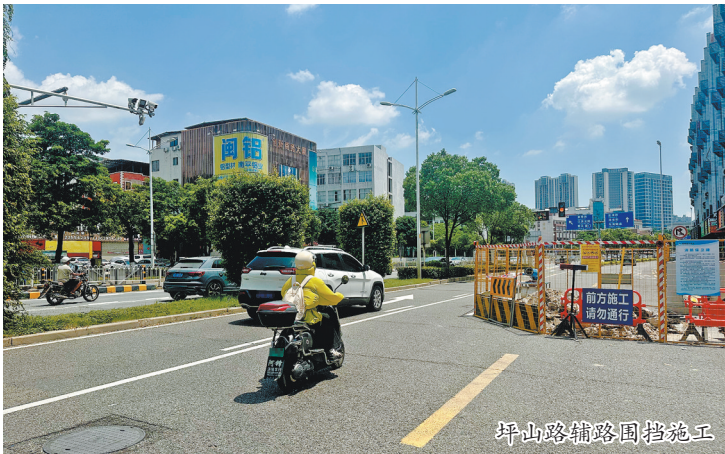
坪山路辅道围挡施工
