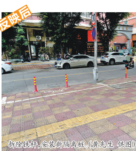
拆除铁杆,安装新隔离桩。(黄先生 供图)
