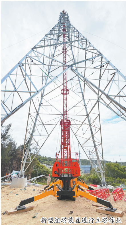
新型组塔装置进行立塔作业
