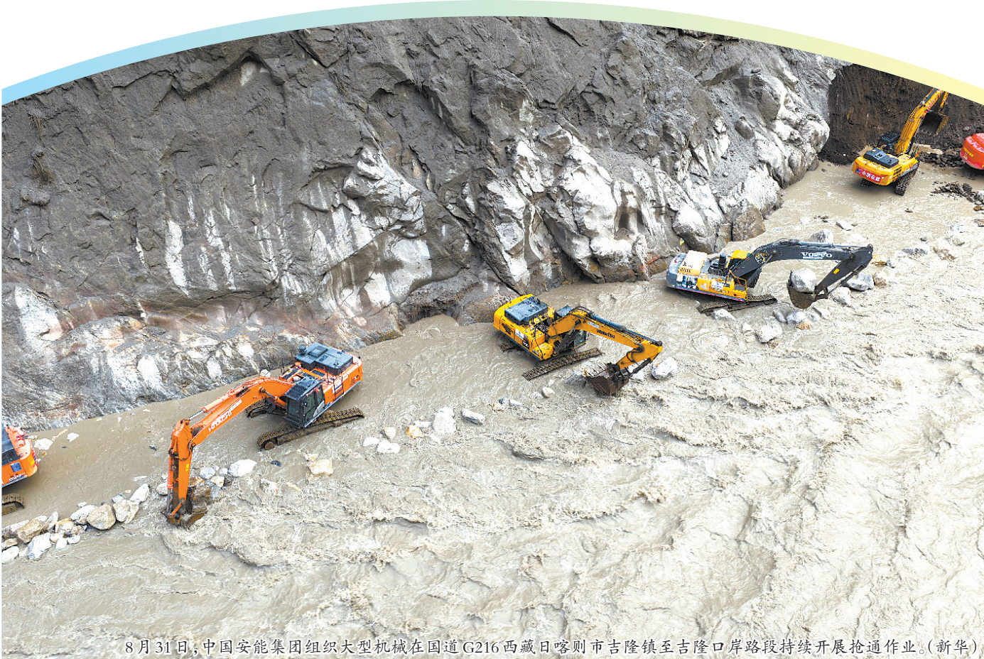
8月31日,中国安能集团组织大型机械在国道G216西藏日喀则市吉隆镇至吉隆口岸路段持续开展抢通作业。(新华)
