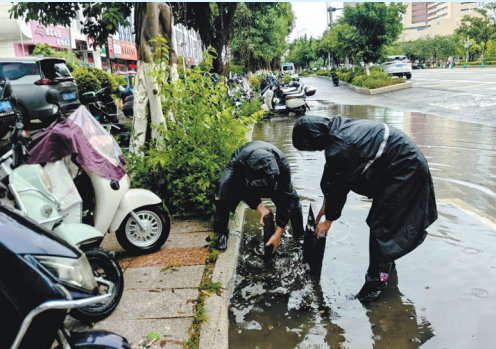
防汛防台期间,城东街道通海社区工作人员清理瑞安街排水口杂物。
