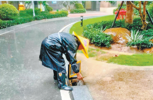
防汛防台期间,东海街道海辰尊域小区物业管理人員在清掏雨水篦子淤积杂物。
