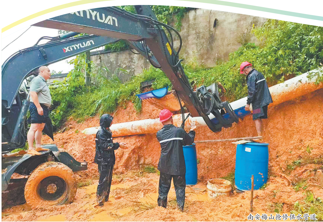
南安梅山抢修供水管道
