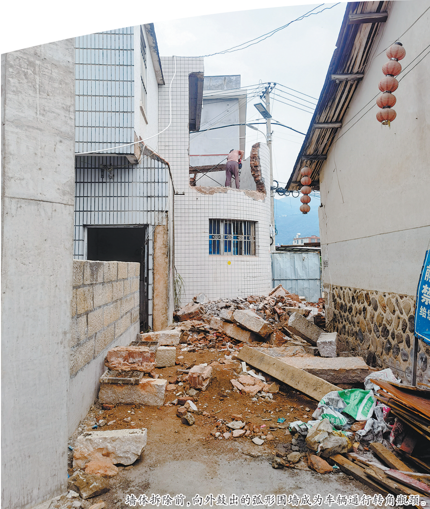
墙体拆除前,向外鼓出的弧形围墙成为车辆通行转角瓶颈。
