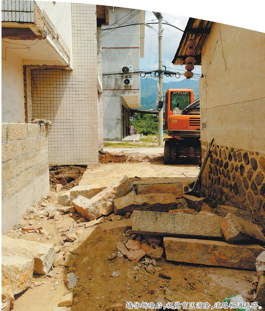
墙体拆除后,视觉盲区消除,道路畅通无阻。
