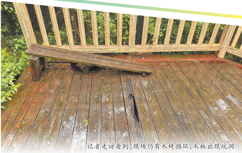
破损台阶已修补
