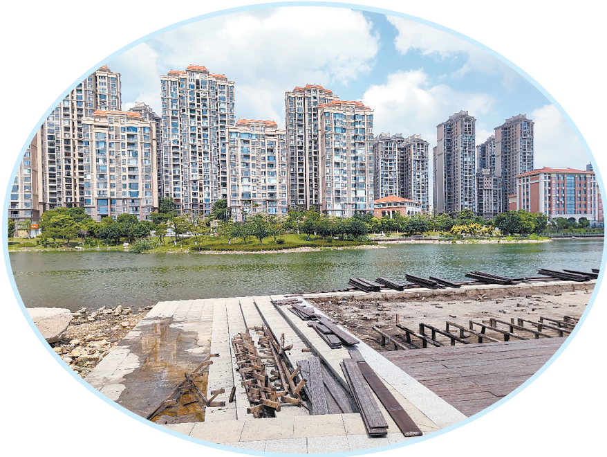
10日起,亲水平台正式启动维修,力争本月底完工。
