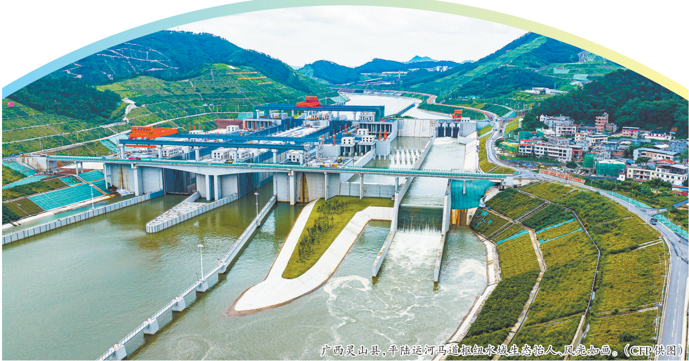
广西灵山县,平陆运河马道坝碧水映生态怡人,风光如画。(CRP供图)
