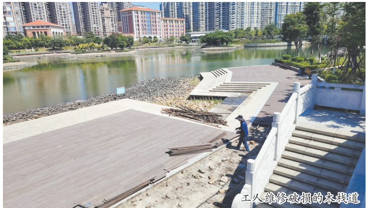
工人维修破损的木栈道
