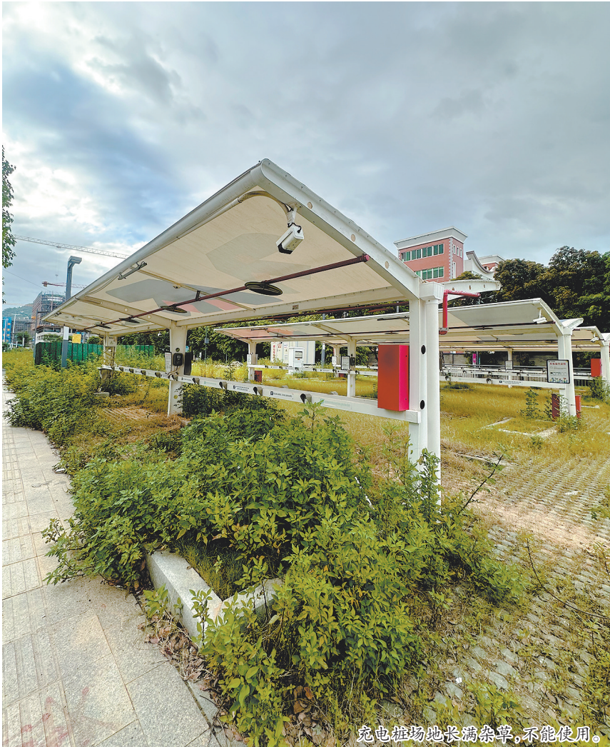
充电桩场地长满杂草,不能使用。
