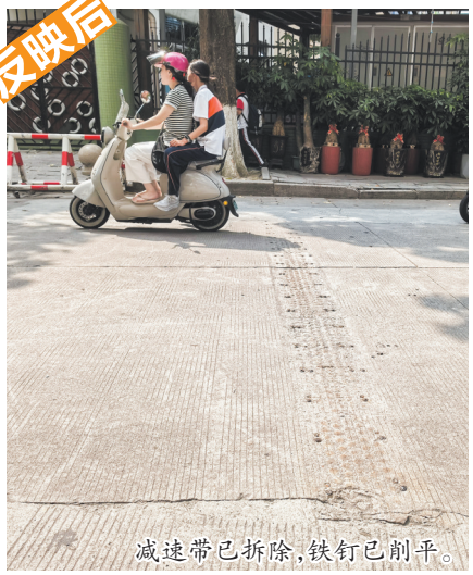
减速带已拆除,铁钉已削平。
