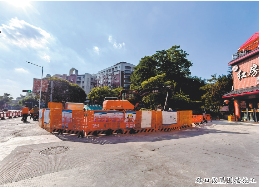
路口设置围挡施工
