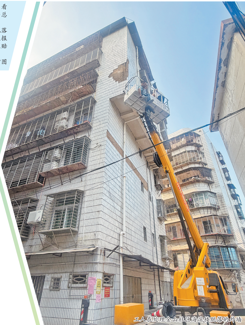
工人在处理金山社区海滨楼脱落的外墙
