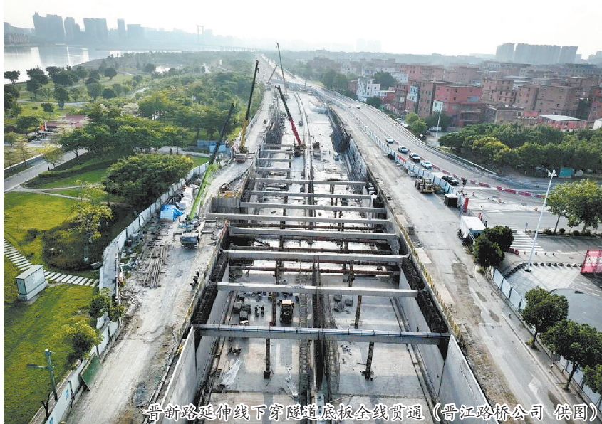
晋新路延伸线下穿隧道底板全线贯通(晋江路桥公司 供图)
