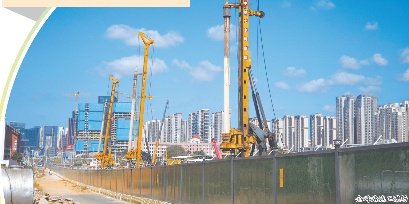
金崎站施工现场
