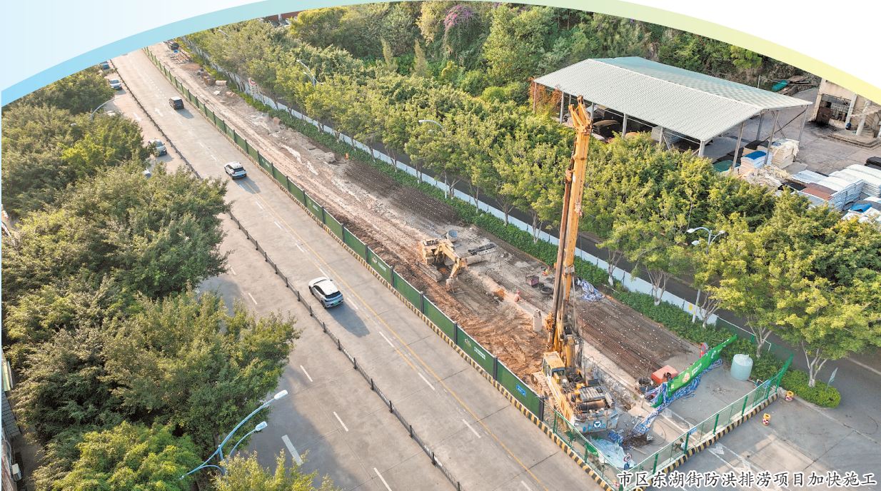
市区东湖街防洪排涝项目加快施工
