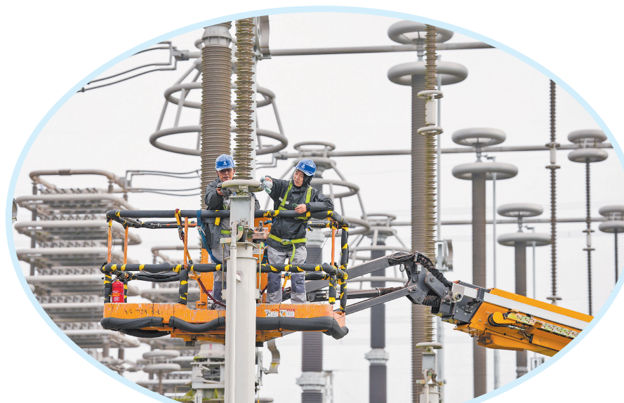
国网安徽电力检修人员在古泉换流站进行检修作业(新华)
