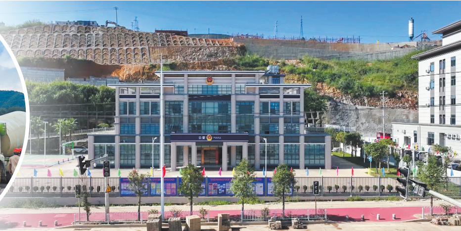
在安溪剑斗新集镇,一批公建配套陆续建成投入使用。
