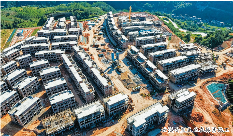
云溪安置点正在抓紧施工
